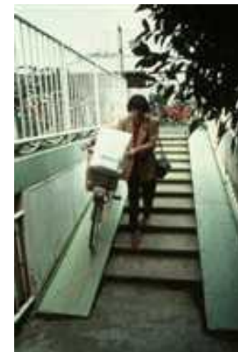
Figura 6.3 Solução com calha para transporte de bicicletas em escadas
